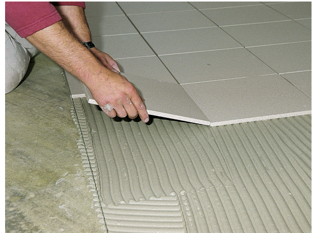
Juokseva olomuoto mahdollistaa ilmataskuttoman kiinnityksen.
