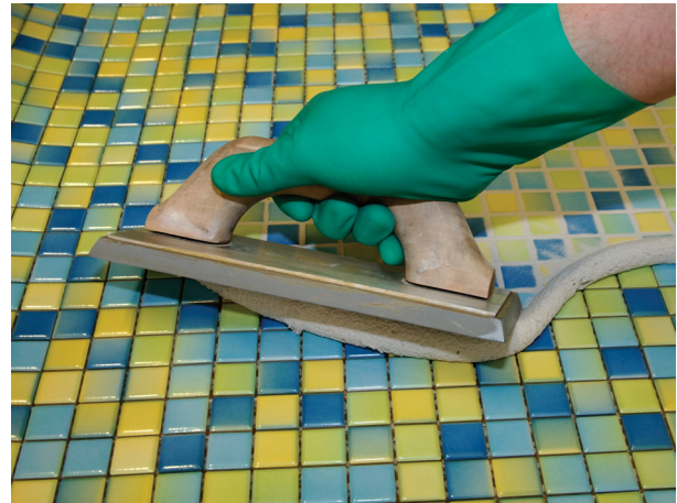
Kemikaalinkestävä ja vettä läpäisemätön PCI Durapox NT tai PCI Durapox NT plus soveltuu mosaiikkilaattojen saumaukseen.
