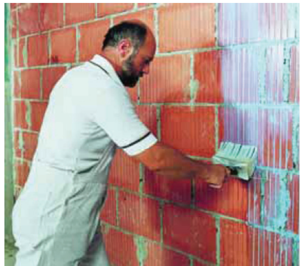
PCI Gisogrund® parantaa rappauksen ja kalkkikiven tartuntaa tiiliseinään.
