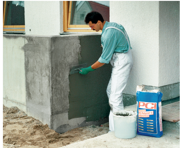
Nopeasti kuivuva PCI Polycrét 5 -tasoite voidaan levittää yhdellä työvaiheella normaalihuokoiselle betonille ilman pohjustetta.
